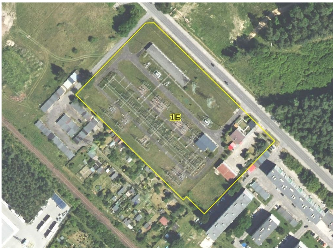
Ryc. 6 Główny punkt zasilania GPZ
